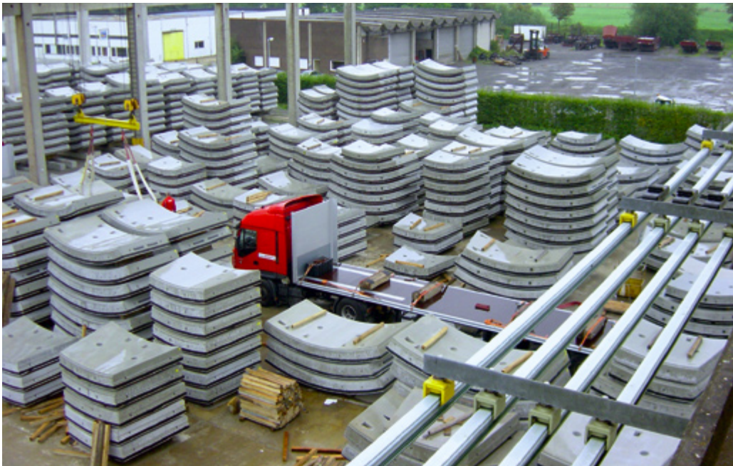
Ca. 2.000 Quadratmeter Fläche für ein Zwischenlager der Betontübbinge
